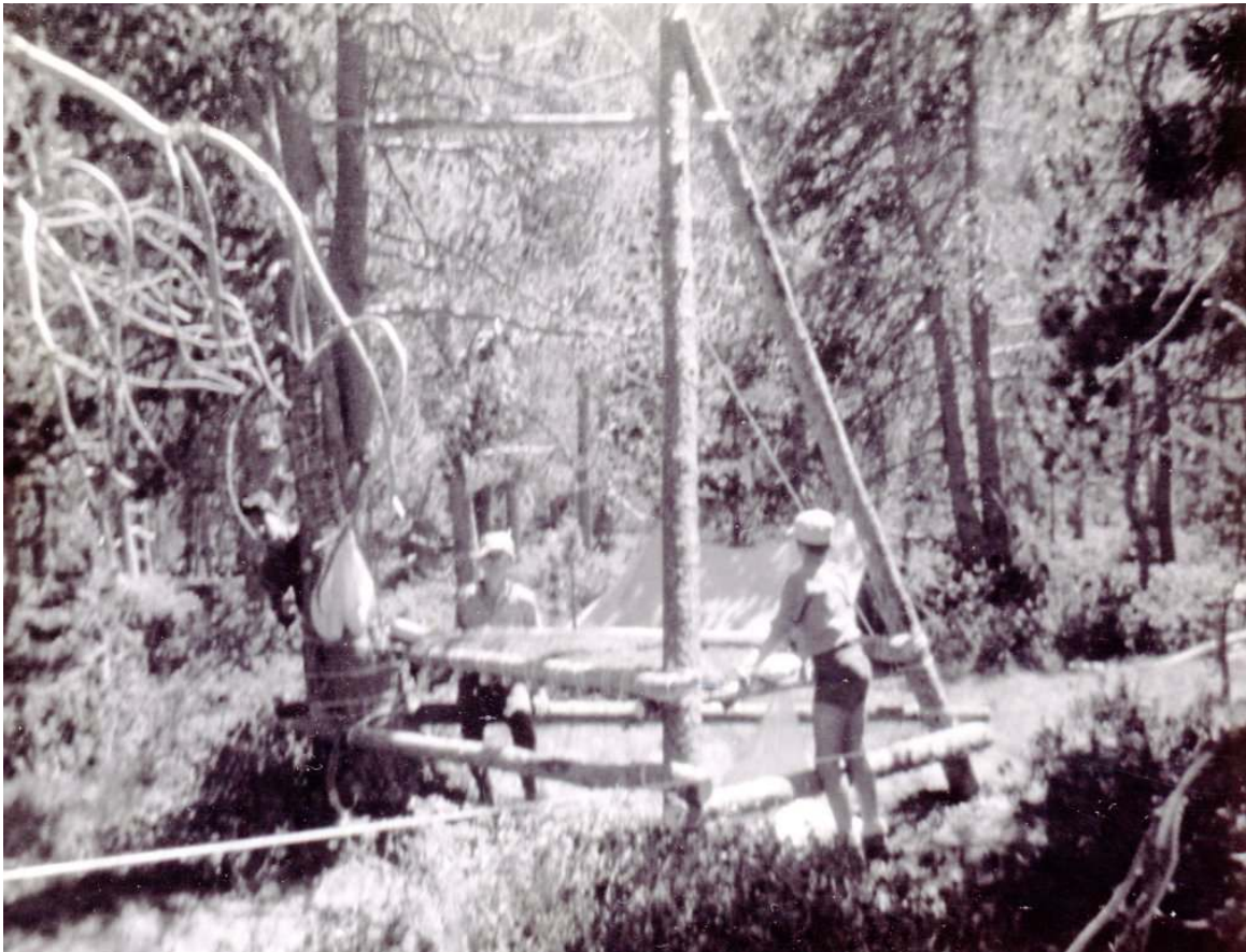
Figura 4.- Campament d'estiu de l'any 1967 al costat del llac de Sant Maurici. L'objectiu va ser construir-nos tots els mobles necessaris per passar tot el campament amb mobiliari fet per nosaltres sense cap clau, si no únicament amb encaixos i lligades de cordill. Aquí estàvem construint la taula de dinar de la patrulla. (AJVMP)
