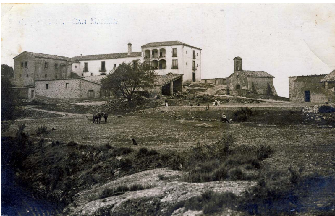
Figura 4.- El mas de "Can Massana" de Rajadell casa de la nissaga familiar per part de la família Vila-Masana a l'any 1910. La casa té un pati central on a la part baixa hi ha els estables del bestiar i a la dreta l'era per garbellar el gra després de la collita. (AJVMP).
