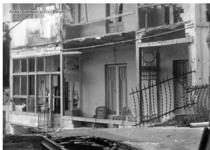
Desperfectes en una casa del centre de Manresa, a conseqüència del bombardeig del 19 de gener del 1939. (Font: web memoria.cat/bombardeigs).
