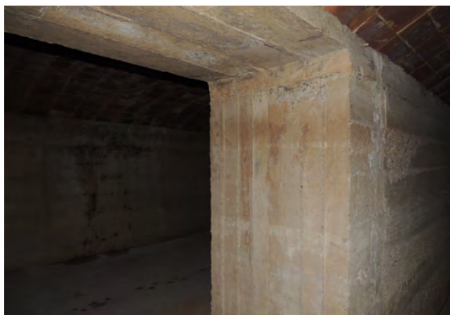
En aquesta foto es poden veure perfectament els 80 cm de paret que hi ha al refugi. Foto feta per Gemma Ribalta.
