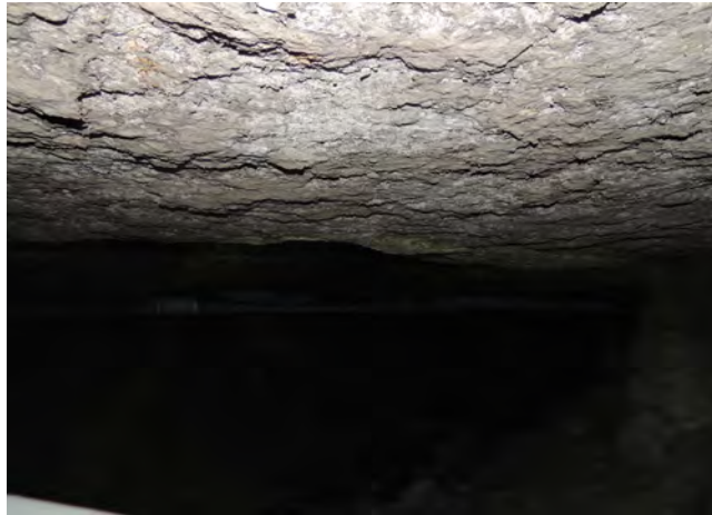
En aquesta fotografia, es veu bé com el sostre del refugi és la pedra de la balma. Fotografia feta per Gemma Ribalta.
