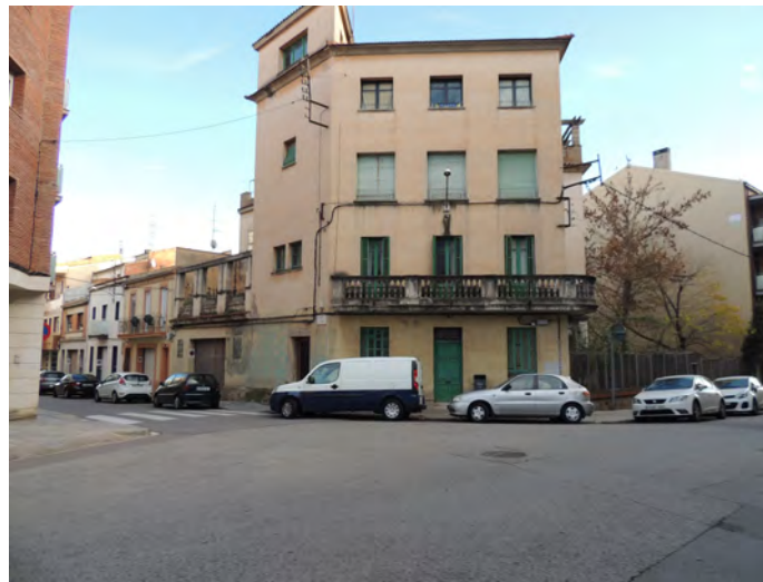
Xamfrà del carrer Llibertat amb el carrer Font, també hi va caure una bomba durant el primer bombardeig. Fotografia feta per Gemma Ribalta.
