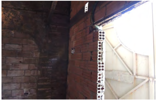
Porta d'entrada al refugi. A la fotografia es veu com hi ha una doble porta, per evitar l'ona expansiva de la bomba. Fotografia feta per Gemma Ribalta.
